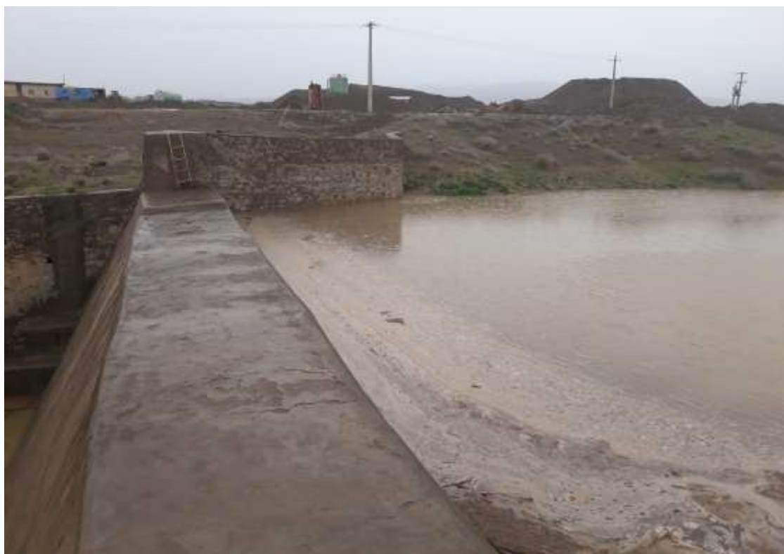
تصویر ۱- بند انحرافی ایستگاه پخش سیلاب بر آبخوان معصومیه قم در هنگام سیل (۶ فروردین ۱۳۹۸)
