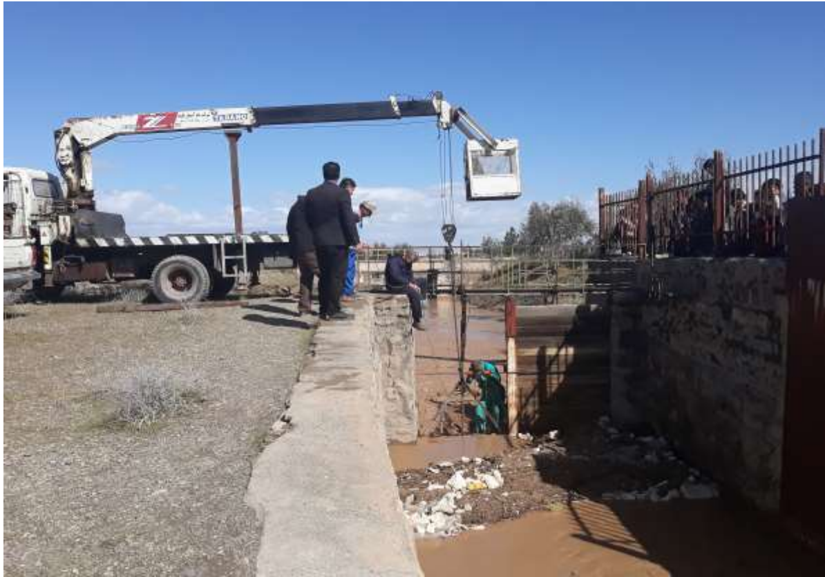
تصویر ۸- بالا آوردن دریچه اصلی کانال انتقال آب ایستگاه پخش سیلاب بر آبخوان معصومیه قم در هنگام سیل (۱۳ فروردین ۱۳۹۸)
