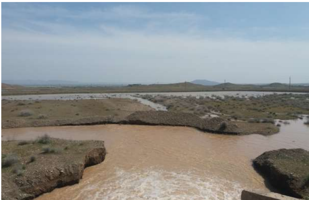
تصویر ۱۵- کانال گسترشی یکی از عرصه‌های پخش سیلاب ایستگاه پخش سیلاب بر آبخوان معصومیه قم در هنگام سیل (۱۷ فروردین ۱۳۹۸)
