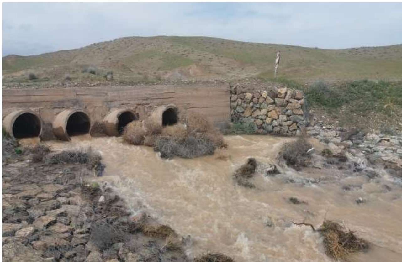
تصویر ۱۶- پل خروجی در انتهای آخرین عرصه پخش سیلاب ایستگاه پخش سیلاب بر آبخوان معصومیه قم (۱۷ فروردین ۱۳۹۸)
